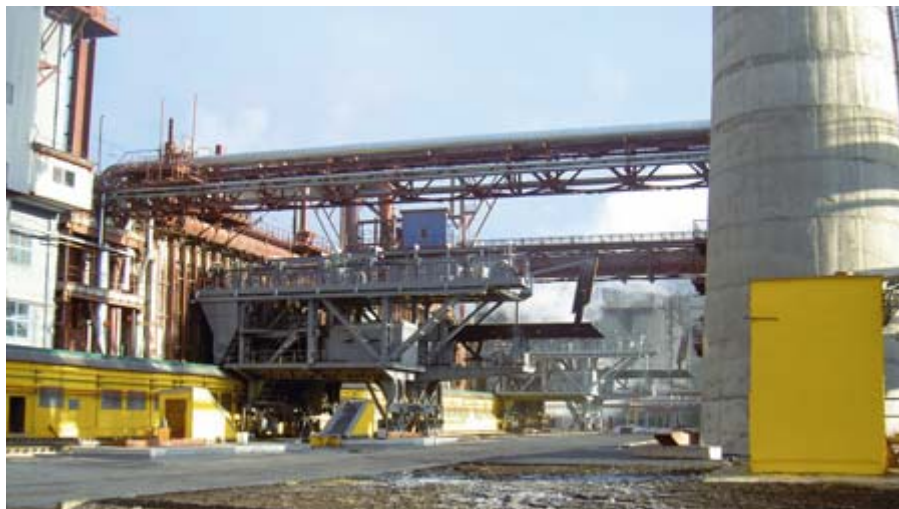
Рис. 1. ОАО «Алтай-Кокс»: коксовая батарея № 5
